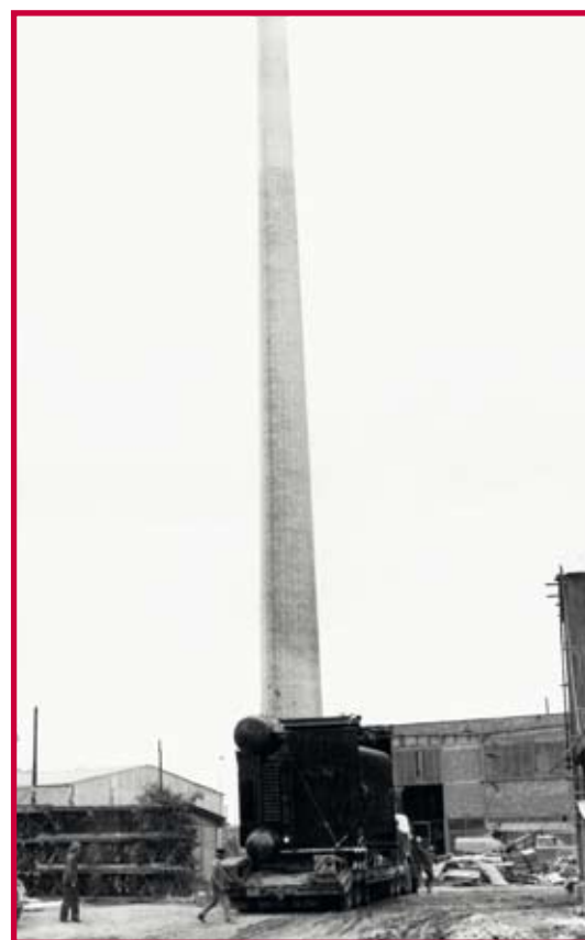
Výstavba komínu, 70. léta minulého století. V současnosti je komín dominantou Havlíčkova Brodu a firmy Pleas.
